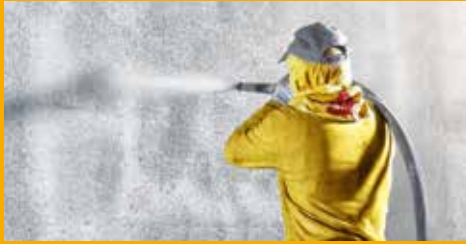
BETONSCHUTZ UND INSTANDHALTUNG
