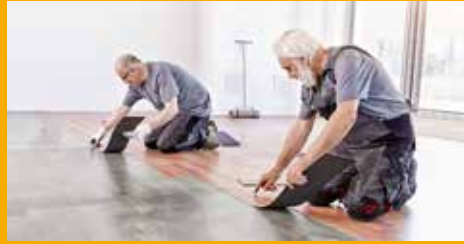
FLIESEN-, WAND- UND FUSSBODENTECHNIK
